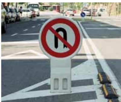
Donde no convienen los postes metálicos.
